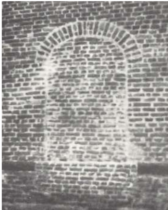
Afb. 11: In de zuidwest(zij)gevel is nog duidelijk de korbogige eertijdse toegang van de eerste Heggekapel (15de eeuw) zichtbaar. Deze toegang werd tussen 1442 en 1477 gedicht. (Foto: W. Van den Branden, 1986)
